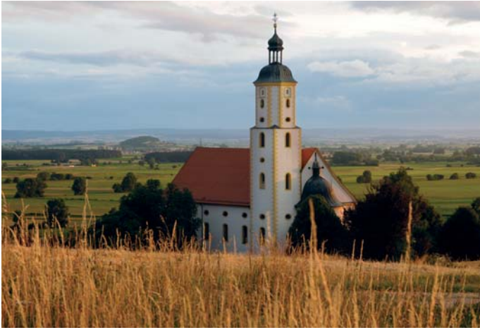
Die Wallfahrtskirche „Maria Brunnlein“ in Wemding.
